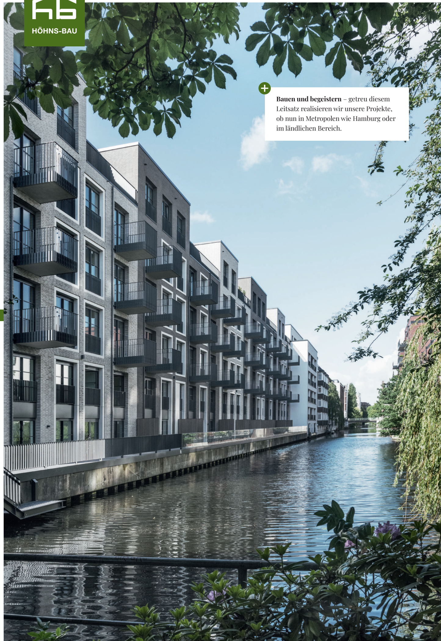
KANALSTRASSE Hamburg, Winterhude
